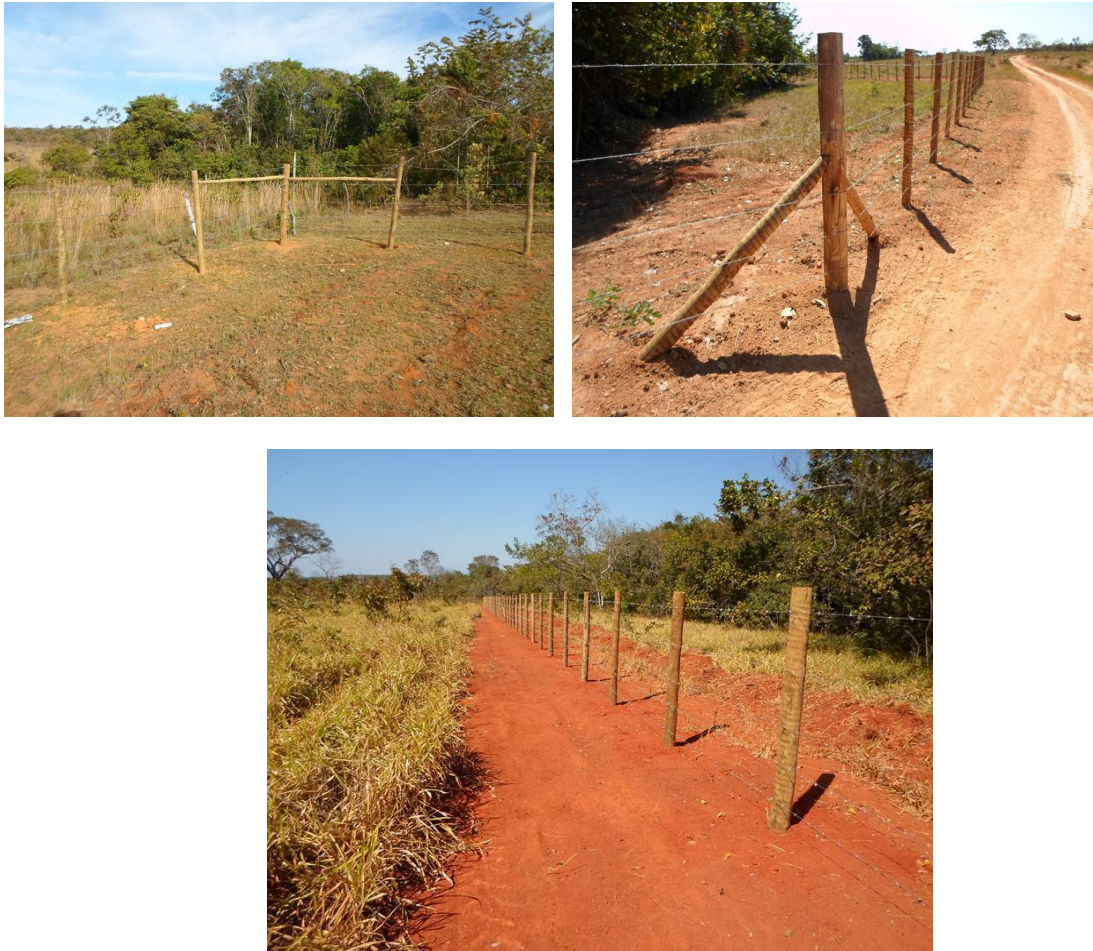
Figura 15: Cercas construídas em projetos hidroambientais na Bacia do Rio São Francisco
